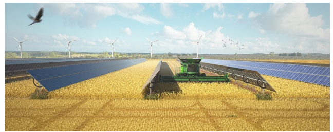
Im Erntemodus werden die Modultische aufgeklappt. Das ermöglicht eine größtmögliche Durchfahrtslichte. © EWS Consulting GmbH
