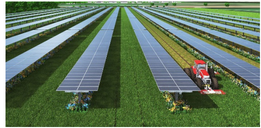
Zum Bewirtschaftungsmodus „Grünland“ werden die Modultische waagrecht gestellt. Darunter kann z.B. gemäht werden. © EWS Consulting GmbH
